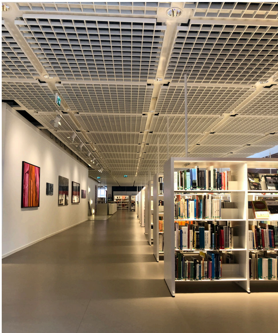
Exempel från Stadsbiblioteket i Jönköping. Integrerad armaturer i hyllan och elanslutning i stålrör upp mot tak.
