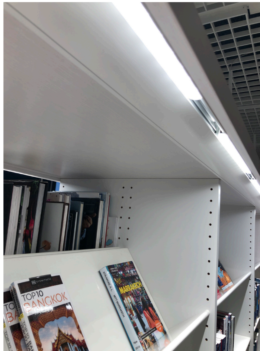
Exempel från Stadsbiblioteket i Jönköping. Integrerad armaturer i hyllan och elanslutning i stålrör upp mot tak.
